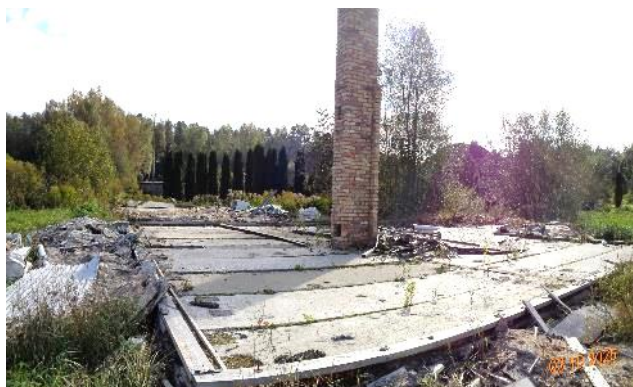
Nojauktās Ēkas pamati (1.daļa)
