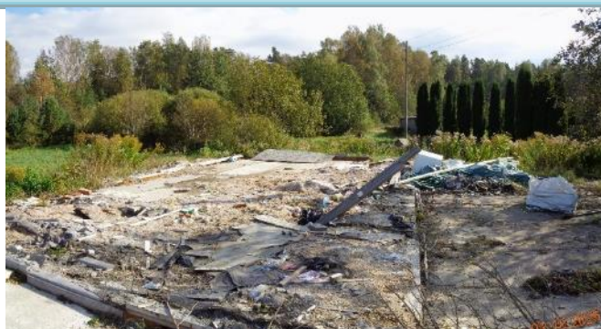
Nojauktās Ēkas pamati (2.daļa)
